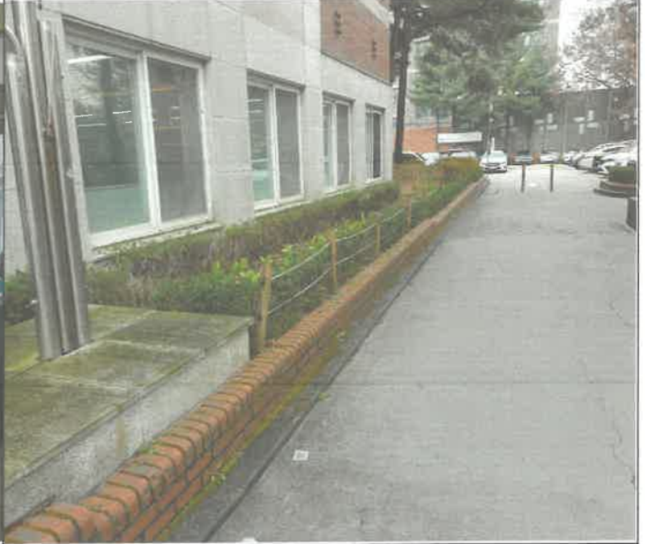
1층 정원 울타리 보수
