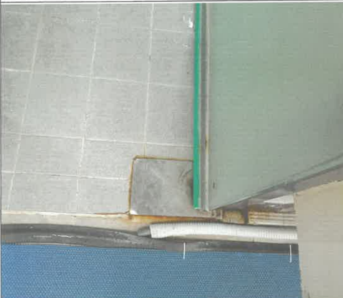
수영장 여자 샤워실 강화문 하부힌지커버 피스 교정 체결
