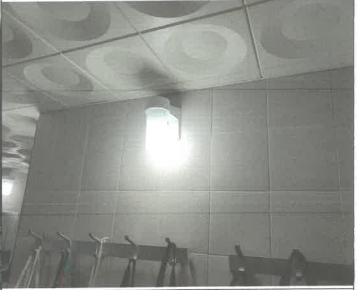
수영장 남자 샤워장 내 전구 1개소 교체
