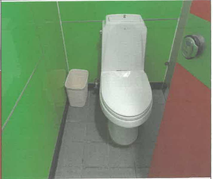
화장실 변기 커버 고정 볼트 파손 교체
