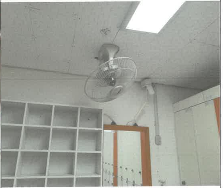
수영장 여자 탈의실 천정형 선풍기 교체 설치
