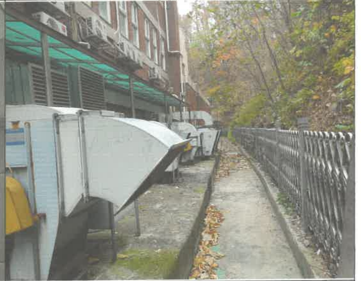
건물 후면 각종 배기팬 점검 및 구리스 주입
