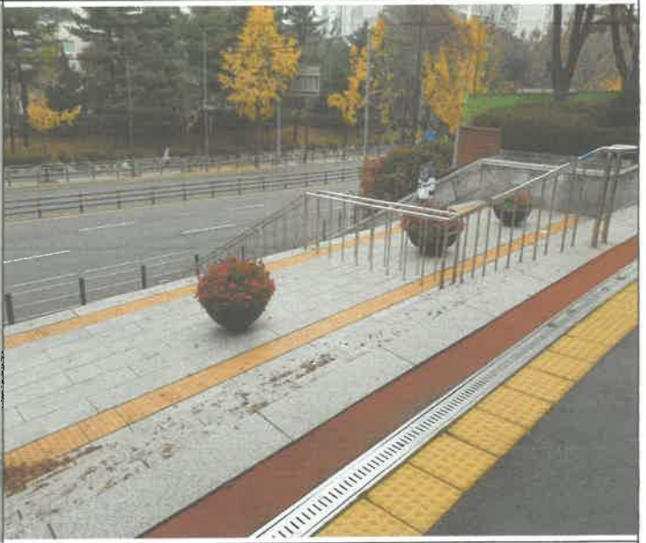
주현관 외부 계단 안전바 용접부위 3개소 탈락 전기 용접 보수작업
