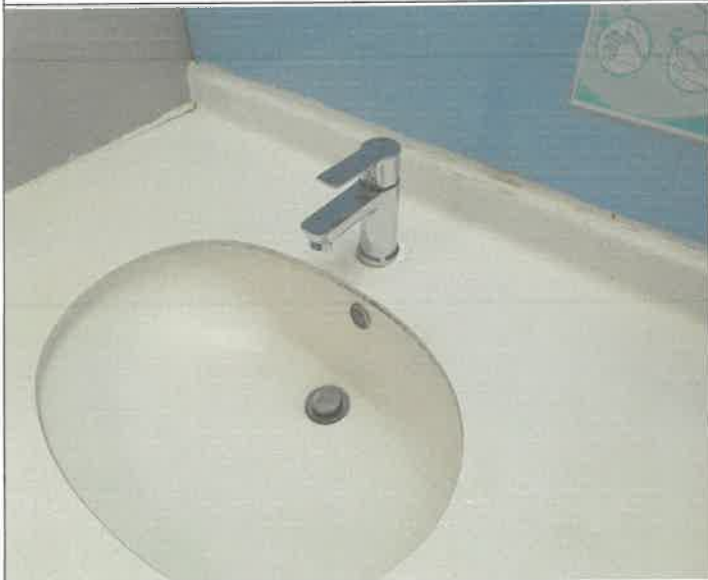
2층 남자 화장실 세면대 수전 교체 1개소
