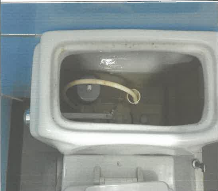
1층 여자 화장실 좌변기 물통 샤워폰 고장 수리
