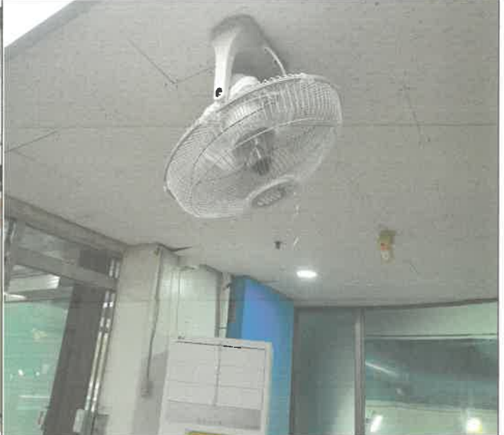
수영장 전망대 천장형 선풍기 설치
