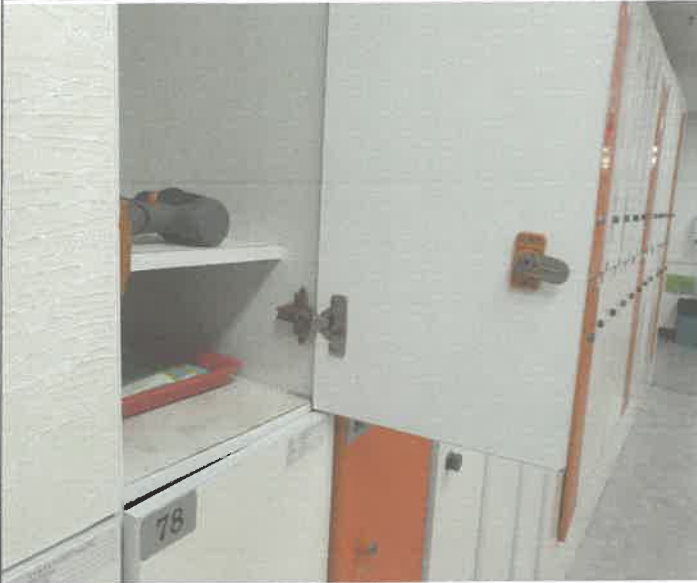
수영장 여자 샤워장 탈의실 락커 경첩 탈거되어 제 부착
