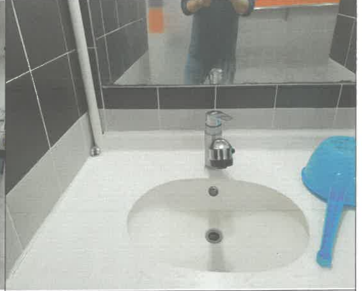
수영장 여자 샤워장 내 세면대 수전 흔들림 고정
