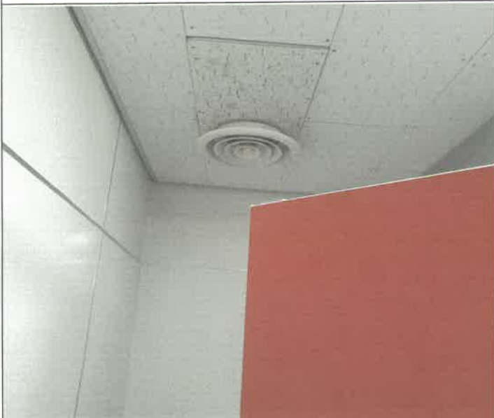
지하1층 여자 화장실 천장 배기 디프셔 재설치
