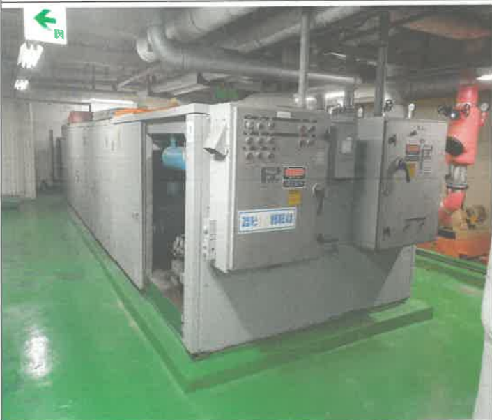
기계실 냉동기, 히트펌프, 냉매가스 회수
