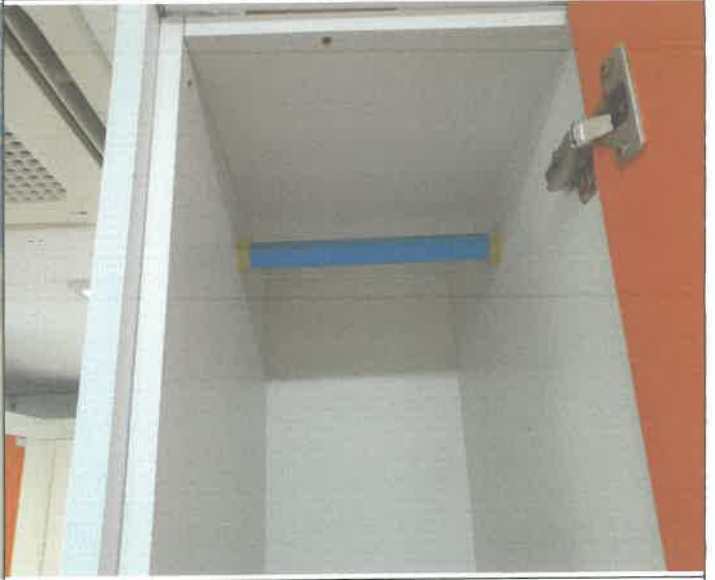
수영장 여자 샤워장 탈의실 락커 옷걸이 파손 보수
