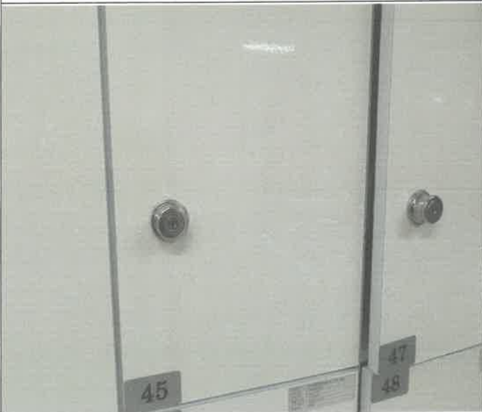
수영장 여자 샤워장 탈의실 락커 키 1개소 교체
